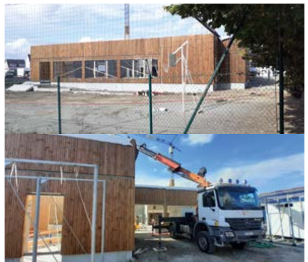
Les travaux de construction du nouveau restaurant scolaire se poursuivent.
