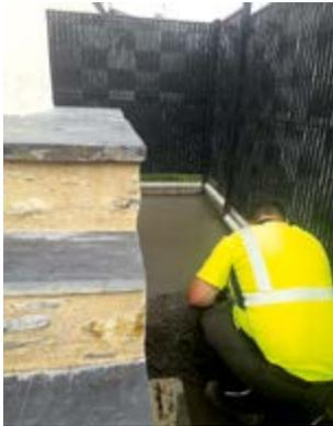
Après l'achèvement des travaux de rénovation du calvaire, le service paysage et environnement a décaissé les abords et coulés 2m<sup>3</sup> de béton. Une légère pente a été respectée afin que les eaux de pluie ne viennent pas dégrader les enduits du nouvel édifice et la chape a été recouverte d'une couche de graviers mettant en valeur tout l'ensemble.
