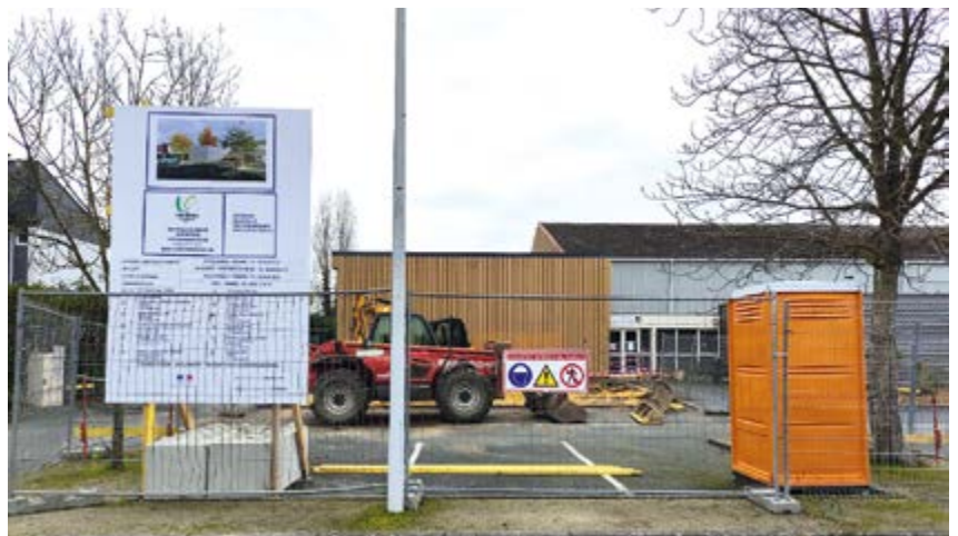
Salle des Troubadours, les travaux sont lancés.
