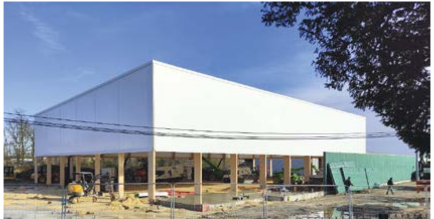
La membrane toile de la troisième salle de sports a été posée.
