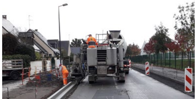
Avec la pose de la bande de roulement, les travaux de l'avenue des Carreaux s'achèvent.
